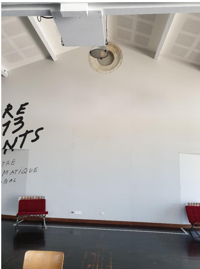
Mur du pignon 2
